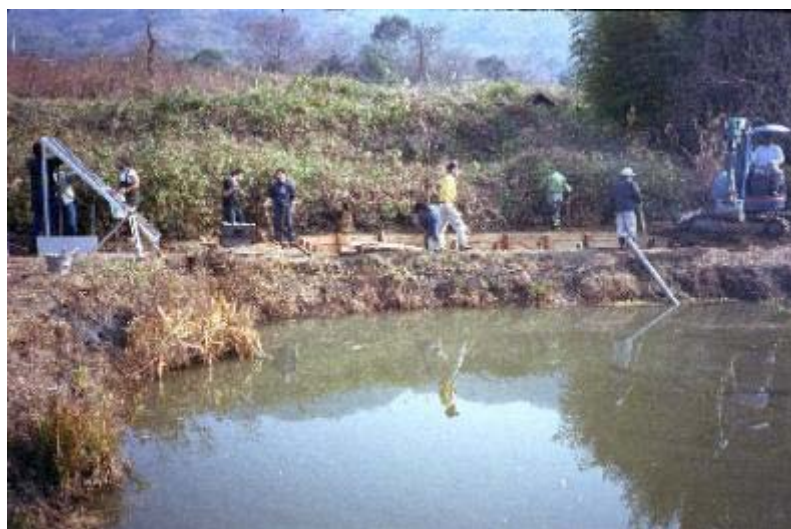
写真6 保護池における水質浄化循環システムの設置工事
