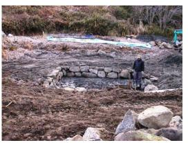
池の構造は二段底にします。内側の深みが約5m×4mで深さは水面から約130cm~120cmになる予定です。まずは、松材の底板をはめ込み、その上に石を積み上げていきます。この内底の一番深いところに底樋の床石を設置します。池のサイズは約12m×12mでの外側の底は最大水深が60cm~70cmになり、山側はドブガイの繁殖場になるように緩やかな傾斜にします。
